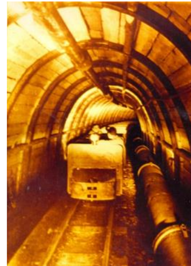
Abbildung 1: Zustand Verbindungsstrecke zu Bergbauzeiten
